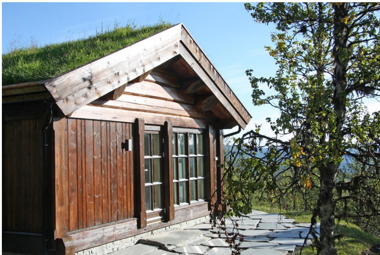
Stavlaft Forskjellen mellom stavlaft-hyttene og stavhyttene er at de siste ikke har laftestokker i gavlene. Denne hytta er i stavlaft. Legg merke til at den har direkte utgang fra stuerommet. Terrassedøren mellom de to stolpene midt på vegg framstår som ett av vinduene. Foto: Anne Mari Lo
