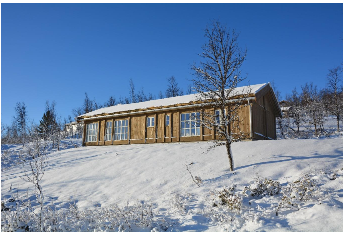
Slipp naturen inn De store vinduene på hyttemodell Gråhø åpner opp for fjellset og utsikten. Stav er den eldste norske byggeteknikken i tre. Stavpanelet og vinduene felles inn mellom stolpene og de langsgående svillene. Foto: Anne Mari Lo
